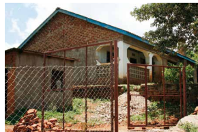
Aus einem alten und maroden Haus ....
