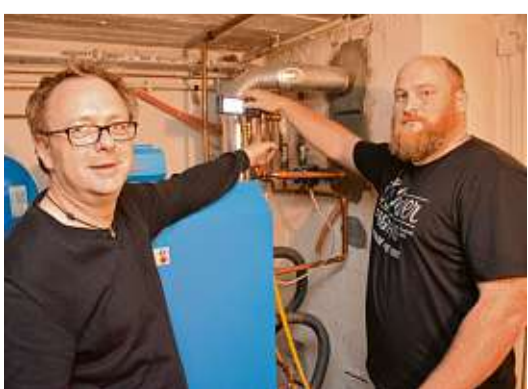
Handwerksmeister Stefan Bolln (l.) und Energieberater Marco Fitzner bei der Datenerfassung in einem Privathaushalt mit einer 20 Jahre alten Heizungsanlage. FOTO: FUCHS
